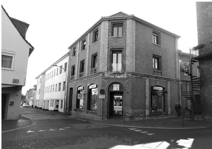
Haus Tollmann, Zülpich, September 2019
